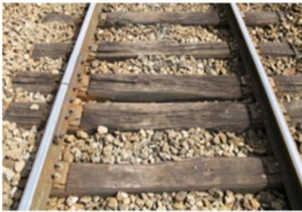
Rails courts sur traverses bois
