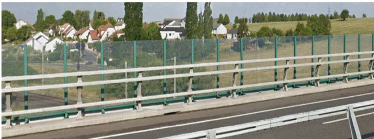
Ecran acoustique panneaux béton et panneaux translucides – RN4 – HERTZING
